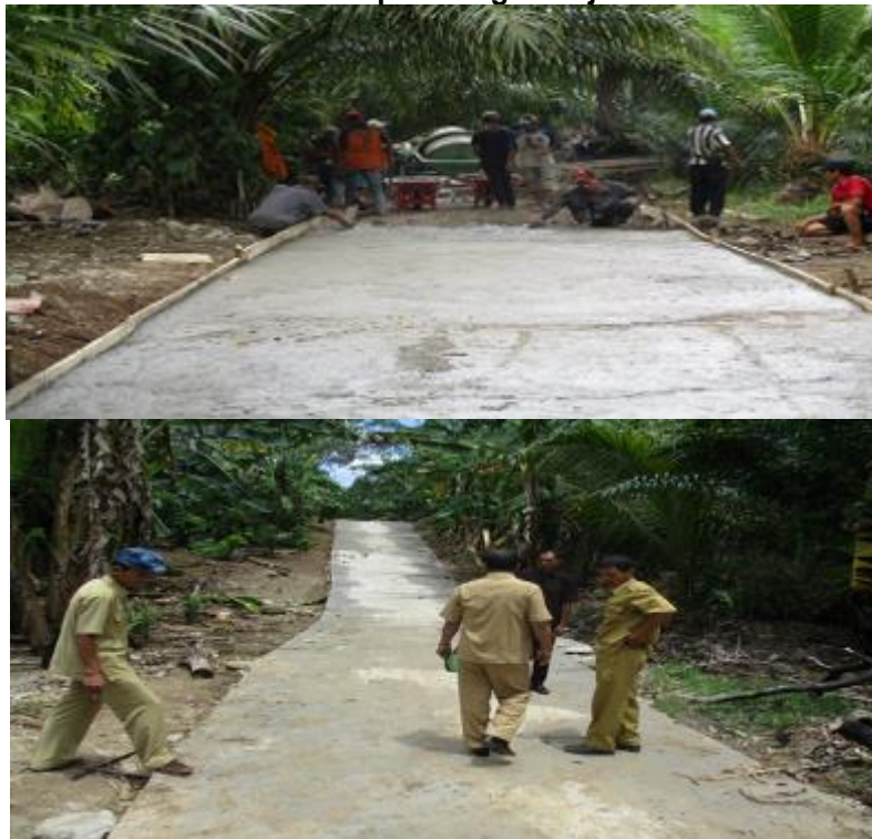
Dokumentasi pelaksanaan pembangunan jalan rabad beton 2020
