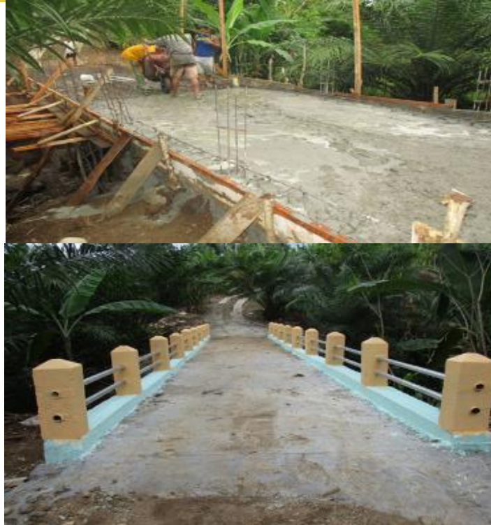
Dokumentasi Pelaksanaan pembangunan Jembatan 2021
