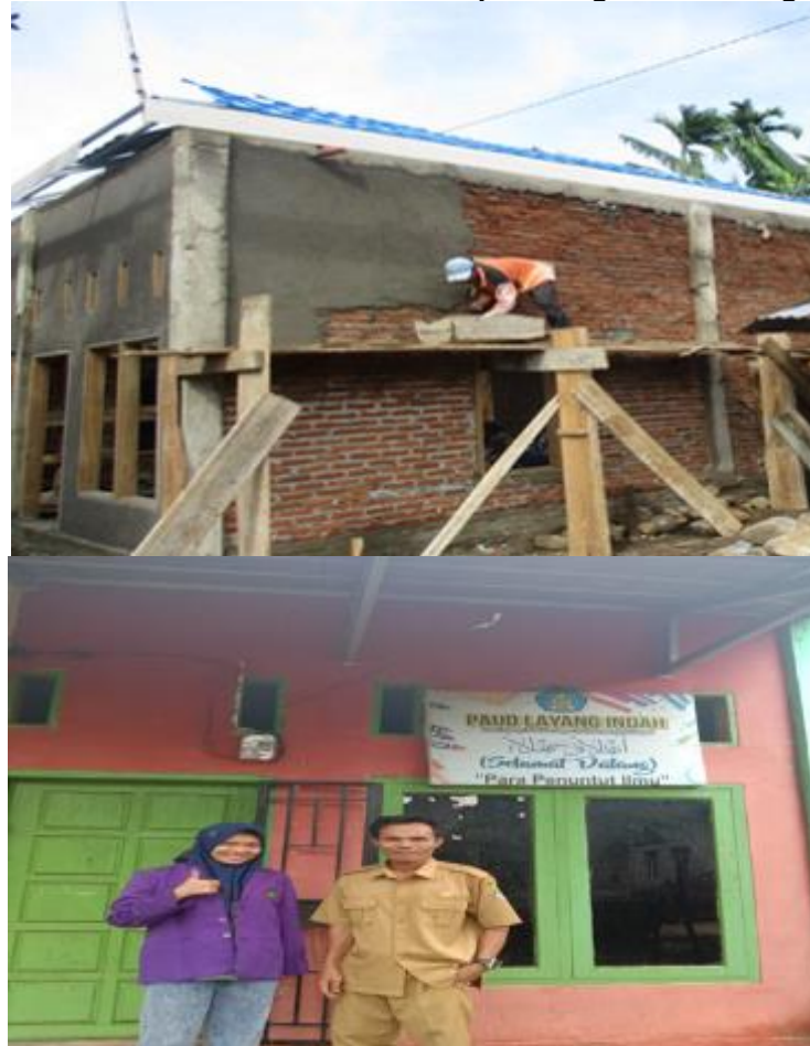
Gambar 1 Dokumentasi Pelaksanaan pembangunan Gedung Paud
