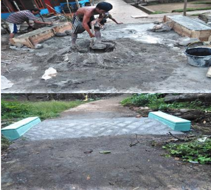
Dokumentasi pembangunan Plat Deker Desa layang Lekat 2020
